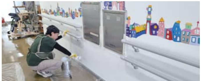
시설 내 페인트 공사
