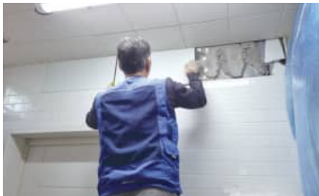
타일 보수 공사
