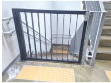
지하계단 안전문 설치
